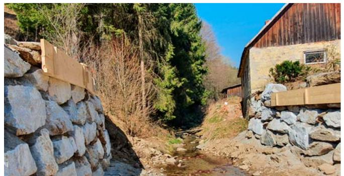
Die alte Brücke beim Anwesen Starkl wurde abgerissen, die Fundamente bzw. die Steinschichtung zur Errichtung der neuen Brücke wurden bereits neu errichtet.
