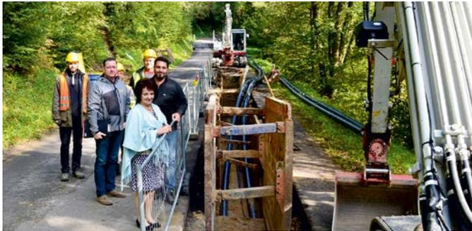
Beim ersten Baulos des zweiten Bauabschnitts werden 2.300 lfm Transportleitung für die Wasserversorgung neu verlegt.
