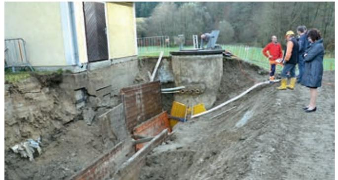
Grabungsarbeiten für die zu sanierende Filterstrecke bei der Brunnenanlage (erbaut um 1980) in Hohenstein
